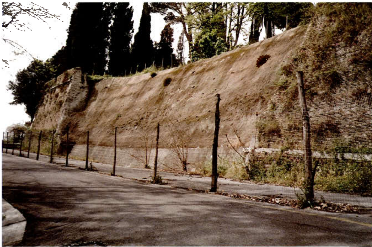
Fig. 5 – Consolidamento delle mura di Villa Sciarra su Via A. Saffi. (foto: M. Pecci).
