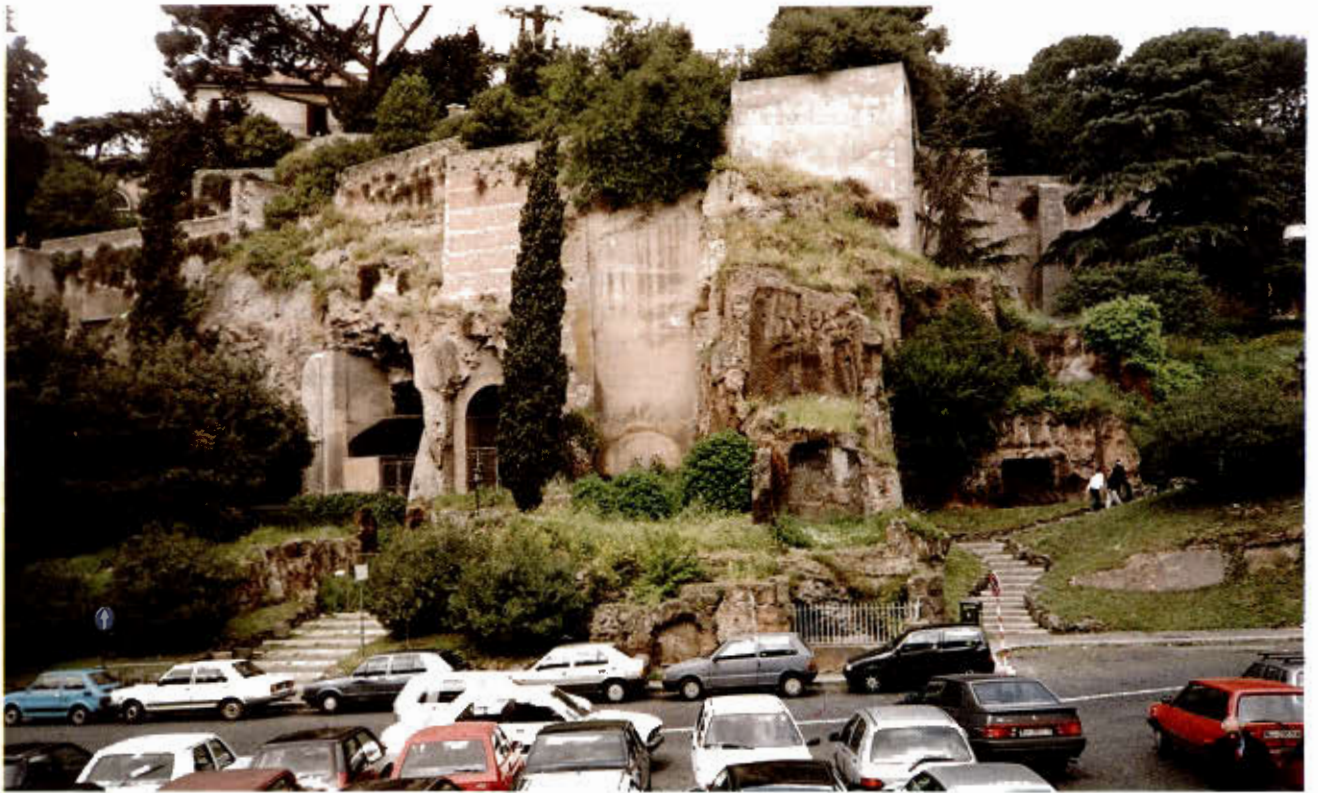
Fig. 8 – Veduta panoramica della Rupe Tarpea (Campidoglio); in primo piano in basso a destra è visibile il contatto tra unità litotecnica litoide (Tufo litoide lionato Auct. ) e unità a comportamento «pseudocoesivo» (tufti Auct. ). (foto: M. Pecci).
