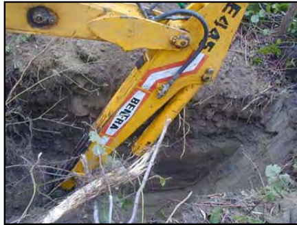
Figura 2 - Scavo della trincea di campionamento
