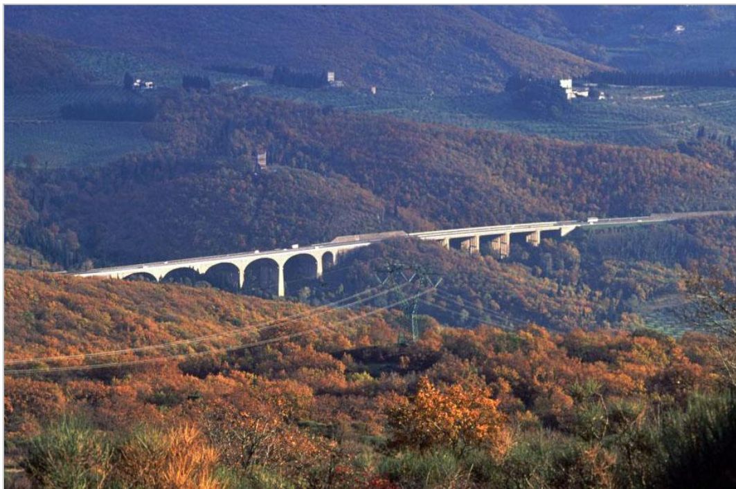
Figura 3.3 - Viadotto dell'Autostrada del Sole A1 in località Calenzano (FI) (M. Bacci). da Rapporto ISPRA 87/2008
