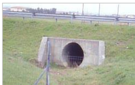
Figura 3.4 - Tunnel di drenaggio delle acque che può svolgere anche funzione di attraversamento faunistico. M. Dinetti da Rapporto ISPRA 87/2008
