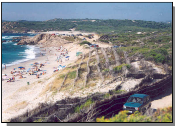
Barriere frangivento in legno (vista lato mare) installate per intercettare la sabbia e proteggere la duna dal calpestio (Foto Fabio Converio, 2002)
