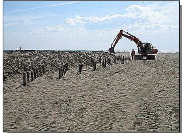
Installazione fascinate per restauro dunale a fine sentiero
