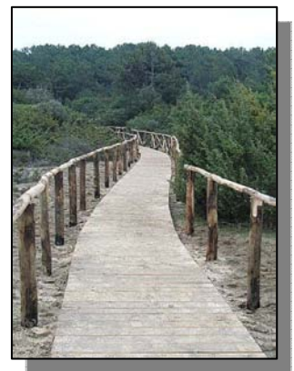
Passerella in legno e sentiero realizzati
