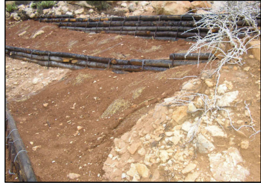
Steccati e palizzate per la riconfigurazione morfologica dei solchi di erosione (Foto Gino Menegazzi - 2006)
