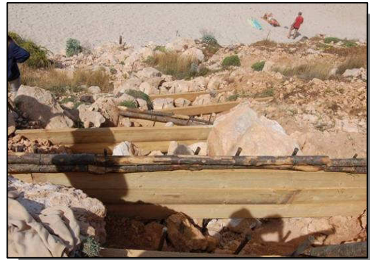
Palizzate per fini antierosivi e per la successiva reintroduzione di piante (Foto Giuseppe Messina - aprile 2006)
