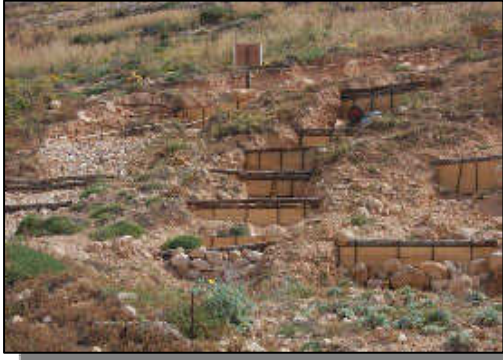
Steccati e palizzate per la riconfigurazione morfologica dei solchi di erosione (Foto Gino Menegazzi - 2006)
