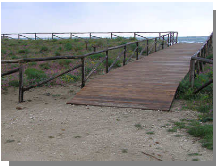
Passerella nei pressi di Torre Vendicari
