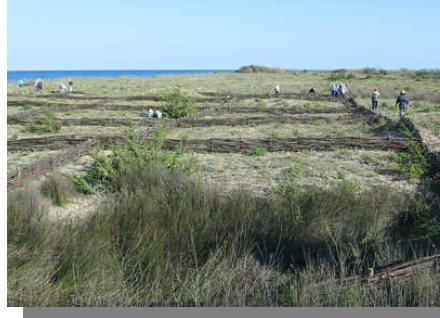
Avanzamento dei lavori per la realizzazione delle barriere frangivento
