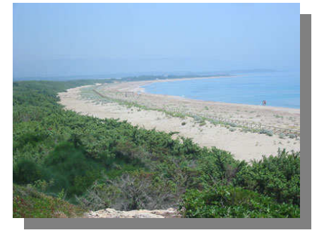
Veduta d'insieme una volta completi i lavori di protezione del cordone dunale
