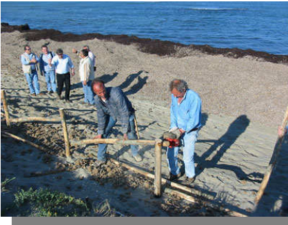
Lavori per la realizzazione della recinzione in legno a protezione del cordone dunale
