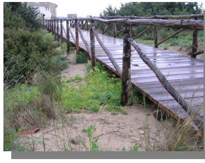
Passerella di attraversamento
