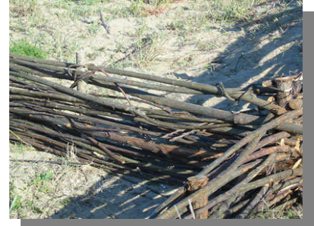
Particolare dell'intreccio delle verghe relative alle barriere frangivento
