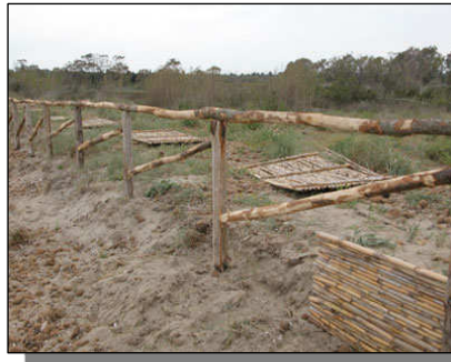
Avanzamento dei lavori della recinzione a protezione del cordone dunale
