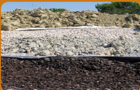
Foto 1 Box 9 Il riutilizzo dei pneumatici tritati per la ricopertura finale consentono il risparmio di migliaia di tonnellate di inerti da cava.
