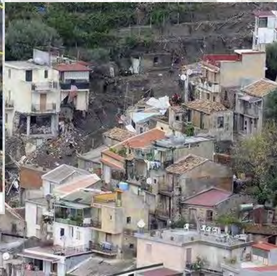
Versanti interessati dall'innescò ed evoluzione delle colate di fango Alvei-strada percorsi e devastati dalle colate rapide di fango e detriti fino alla fiumara
