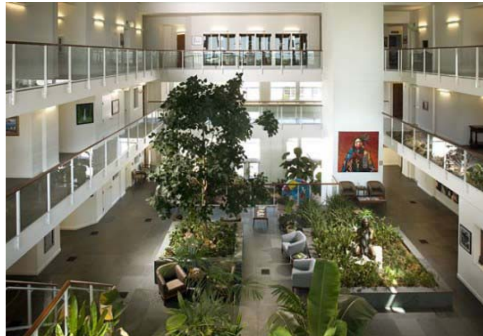
San Francisco Public Utilities Commission "Living Machine" impianto di fitodepurazione indoor per il riciclo acque grigie nei WC e per l'irrigazione
