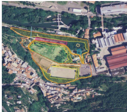
Veduta aerea del sito "ex discarica di Papigno" nella zona centrale con campitura verde l'area di realizzazione del phytocapping.
