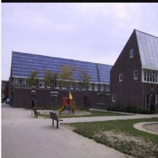
I pannelli fotovoltaici per la produzione di energia elettrica possono essere completamente integrati nell'edificio anche come elemento funzionale: pensiline di ingresso, parapetti di balconi, elementi frangisole. Si possono integrare completamente in falda o in parete come elemento architettonico. Inseriti nelle vetrate hanno la duplice funzione di schermare la radiazione solare ed accumulare calore per la produzione di energia elettrica.
