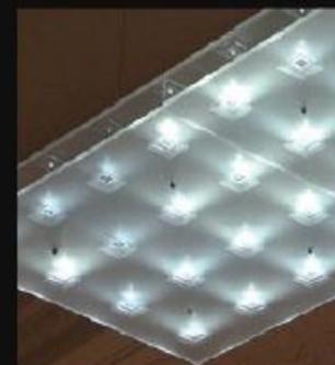
SISTEMA PER CAPTAZIONE DELLA LUCE SOLARE E TRASFERIMENTO ALL'INTERNO DI AMBIENTI CHIUSI ATTRAVERSO CAVI DI FIBRA OTTICA
