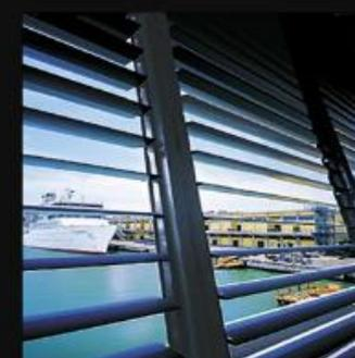
frangisole a lamelle orientabili permettono di regolare il flusso luminoso in relazione alle esigenze del locale illuminato
