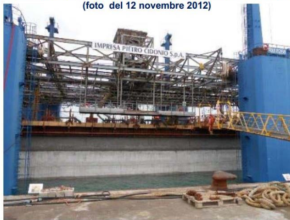
il primo cassone REWEC3, in fase di costruzione a Civitavecchia (foto del 12 novembre 2012)
