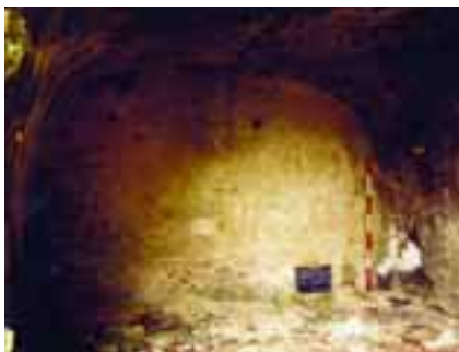
Cisterna della villa in località Tarallo (s.a.)
