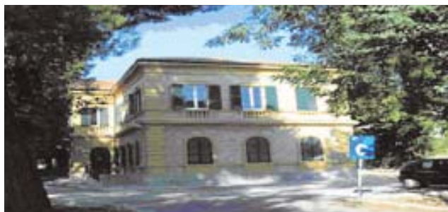
Panoramica della nuova sede ARPAM di Ancona.
