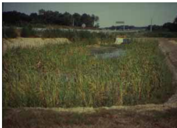
Foto 89 – Vasca di prima pioggia con funzione di fitodepurazione (Francia – Foto P. Cornellini)
