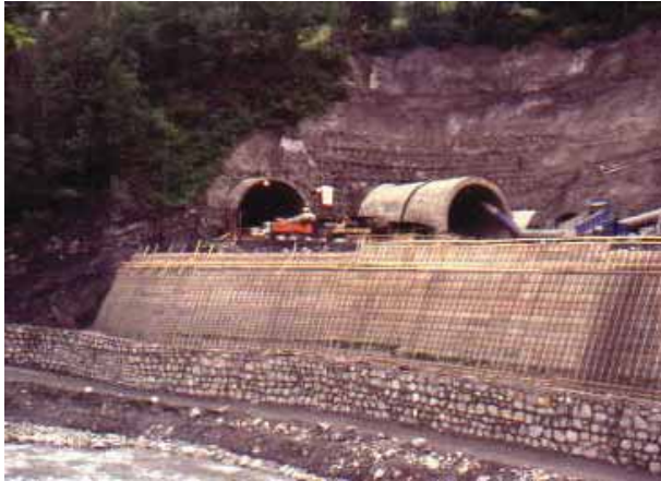
Foto 61 - TRV Autostrada Aosta-M.Bianco svincolo di Morgex. Durante la costruzione (Foto G. Sauli 1988)
