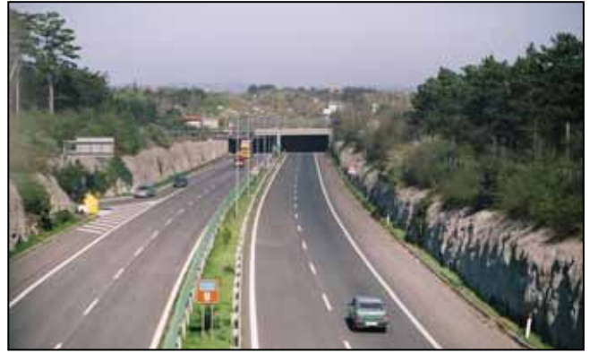
Foto 94 – Galleria artificiale rivegetata con funzioni di continuità faunistica (Grande Viabilità Triestina loc. Prosecco – Foto G. Sauli)
