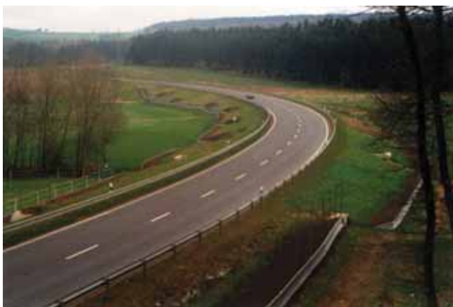
Foto 105 - Strutture metalliche di svio per anfibio collegate con diaframmi direzionali e sottopassi (Germania). Foto G. Sauli
