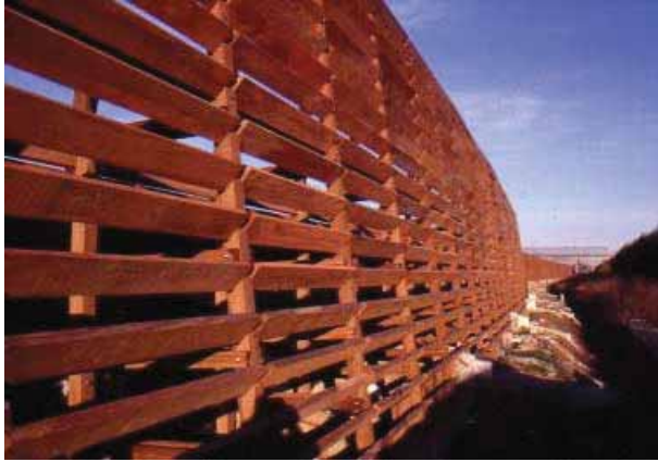
Foto 73 – Barriera antirumore in legno in costruzione (Autobrennero). Foto G. Sauli
