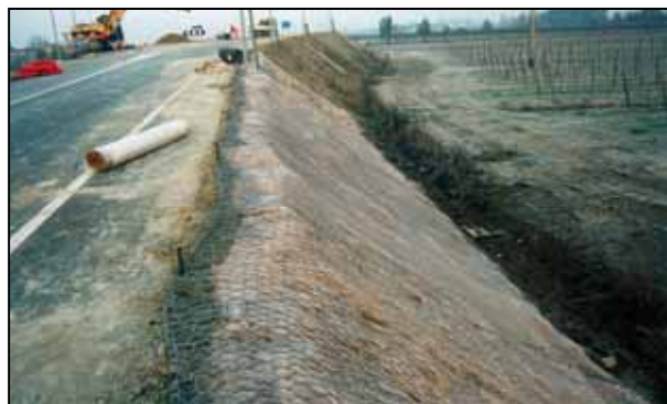
Foto 124 - Rivestimento vegetativo in rete metallica e stuoie organiche con semine e messa a dimora di talee di salice su rilevato in argille stabilizzate a calce (SP 56 S. Donà VE – Foto G. Sauli 2004)
