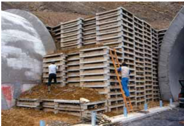
Foto 63 – Muro cellulare di sostegno di terrapieno tra gallerie. (GVT Servola TS – dicembre 1987. Foto G. Sauli)
