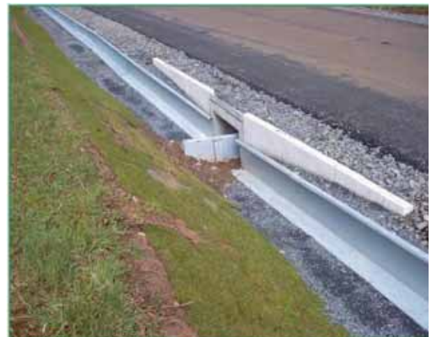
Foto 104 - Strutture metalliche di svio per anfibi collegate con diaframmi direzionali e sottopassi (Germania). Foto G. Sauli
