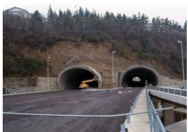
Foto 10 - GVT Galleria di Servola (TS) – 1987 (Foto G. Sauli)
