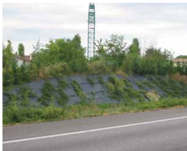
Foto 20 – Impiego di teli pacciamanti a protezione di specie arbustive. (foto G. Sauli)
