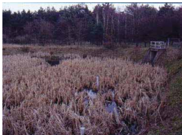
Foto 90 – Vasca di prima pioggia con funzione di habitat umido e fitodepurazione (Germania – Foto G. Sauli)
