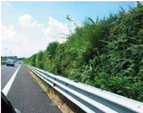
Foto 77 – Barriera antirumore in cls vegetata (Tangenziale di Mantova - Foto R. Santero)
