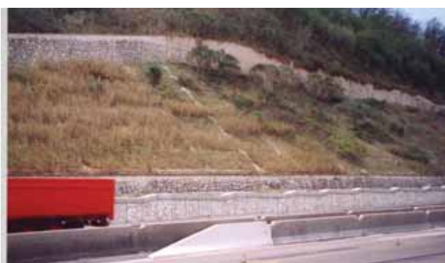
Foto 41 - Autostrada tratto Fiano-Orte stabilizzazione di scarpate in argilla soggette a franamento con mantellate in cls (Foto G. Sauli)
