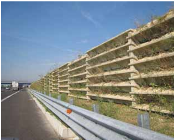
Foto 75 – Barriera antirumore in terrapieno compresso in cls vegetata (Passante di Mestre). Foto G. Sauli 2009
