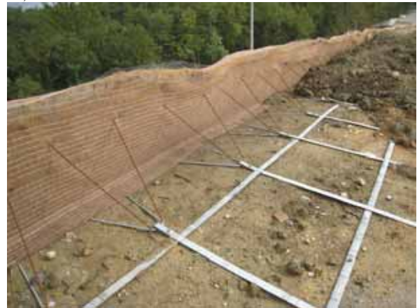
Foto 52 - TRV con rinforzi orizzontali in armature metalliche e stuoie in cocco come antiersosivo. Si noti la terra vegetale appressata alle stuoie e reti esterne. (SP 73 Siena – Foto G. Sauli 2009)
