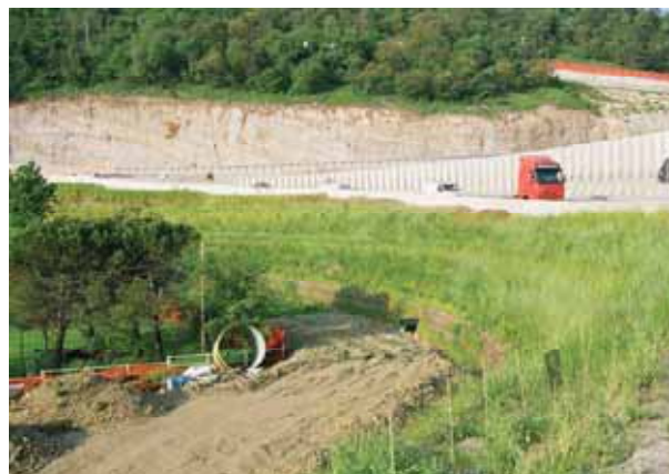
Foto 14 - Esempio di prerinverdimento: costruzione e rinverdimento di terre rinforzate verdi (GVT - curva di Cattinara - Foto G. Sauli)
