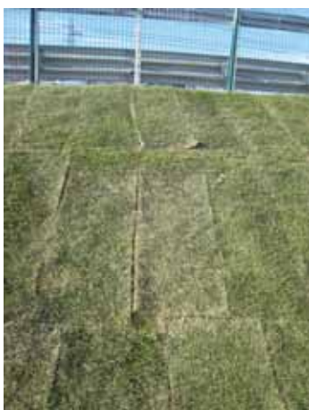
Foto 16 – Rivestimento di scarpata con prato in rotolo con problemi iniziali di possibili scollature (Grande viabilità Trieste zona Padriciano - Foto G. Sauli 2008)
