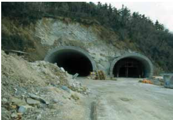
Foto 9 – GVT Galleria di Servola (TS) – 1986 (Foto G. Sauli)
