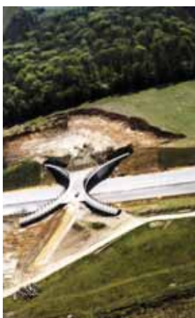
Foto 97 – Ponte per ungulati con strutture di invito ad imbuto (Lussemburgo anni '80). Foto G. Sauli
