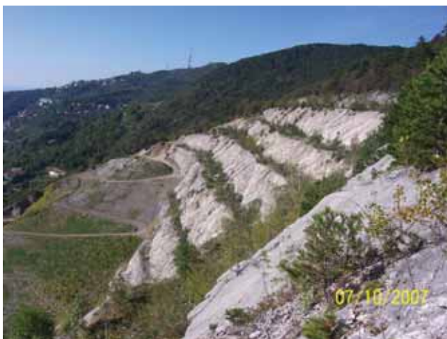
Foto 113 – Ricomposizione morfologica di una cava di calcare di versante con smarino di scavi da gallerie della Grande Viabilità di Trieste (Cava Faccanoni – TS 2007). Foto G. Sauli
