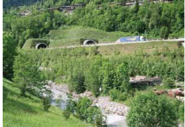
Foto 62 - idem dopo 18 anni. Si noti la crescita rigogliosa di arbusti ed alti arbusti che maschera completamente la struttura (Foto G. Sauli 2006)
