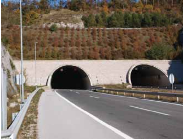
Foto 6 - Soluzioni intermedie sono talvolta necessarie per morfologie locali (autostrada in Slovenia loc. Sezana – Foto G. Sauli)
