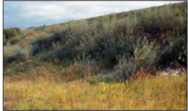
Foto 22 - Piantazione di arbusti autoctoni e talee di salici arbustivi pionieri ( Salix elaeagnos , S. purpurea ) a gradonata su rilevato autostradale su ghiaie calcaree da scavi privo di suolo vegetale Carso triestino Loc. Aurisina (GVT - TS) – Foto G. Sauli 1991
