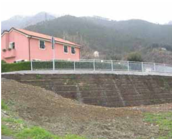
Foto 59 - TRV in reti sintetiche rinverdite (Foto G.P. Pinzani 2009)
