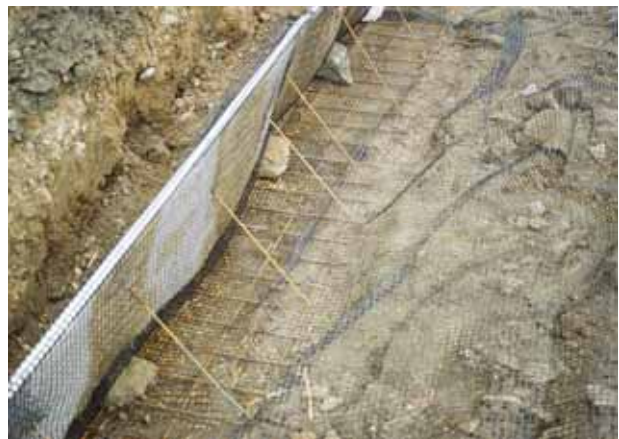
Foto 54 - TRV con armatura orizzontale in reti sintetiche (GVT loc. Domio – Foto G. Sauli 2008)
