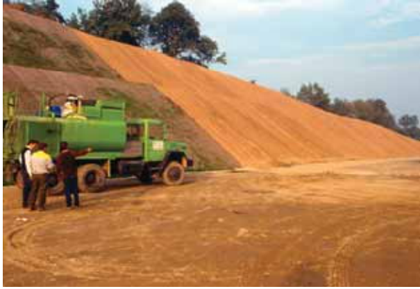
Foto 45 - Stuoie in cocco su scarpate in scavo in litologie sabbiose non sempre hanno assolto alla funzione di stabilizzazione essendo dei provvedimenti antierosivi (Autostrada dei trafori – ottobre 1988 – Foto G. Sauli)
