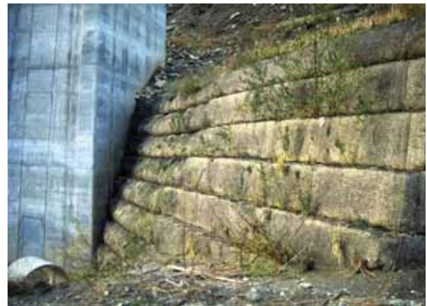
Foto 58 - TRV in reti sintetiche con talee di salice (autostrada del Frejus anni '80 - Foto P. Fantini)
