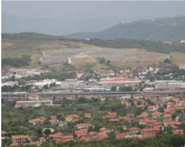
Foto 114 - Ricomposizione di morfologie a terrazzi finalizzato ad uso agricolo e rinverdimento di notevoli cubature di smarino di galleria (Grande Viabilità Trieste – gallerie M.D’Oro - in opera – Foto G. Sauli)
