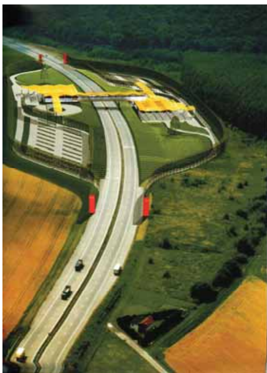
Fig. 3 - Totalfinaelf, Belgio (Samyn & Partners) A8 Highway, Hellebecque, Belgio Fonte: Infrastructure Scape, Area 79, Marzo 2005
