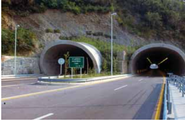
Foto 11 - GVT Galleria di Servola (TS) – 1988 (Foto G. Sauli)
