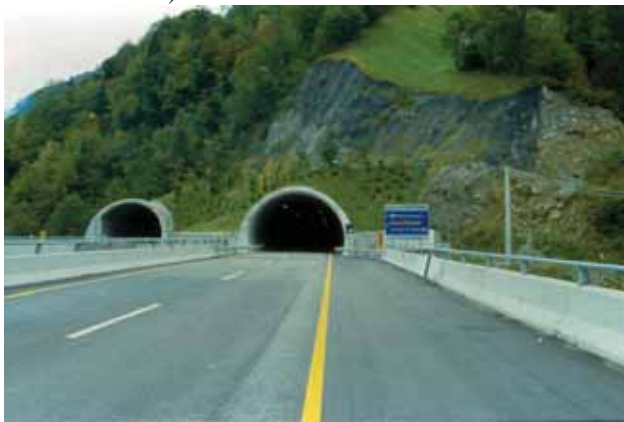
Foto 7 - Prolungamenti in galleria artificiale con rilevati rivegetati ad alberi locali (Autostrada A 23 galleria di Pontebba – Foto G. Sauli ottobre 1987)
