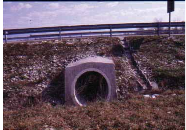
Foto 100– Passaggio per fauna a tubo (Collegamento Cimpello – Sequals – PN – Foto G. Sauli)
