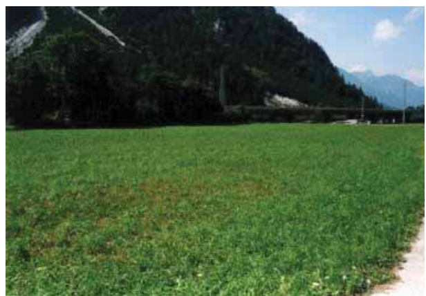
Foto 117 – idem ripristino a prato dell’area di cantiere.
