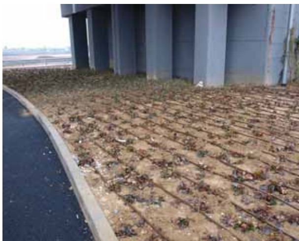
Foto 87 – Impiego di edera tappezzante con impianto di irrigazione a goccia all'ombra del viadotto (Viabilità d'accesso alla nuova zona commerciale di Villesse – GO) febbraio 2010. Foto G. Sauli
