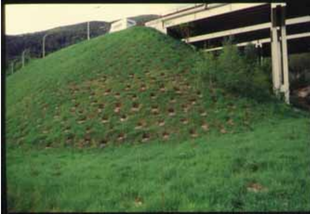
Foto 3 -Rivegetazione ad arbusti di un rilevato spalla di viadotto (Autobrennero – Bolzano nord – Foto G. Sauli)
