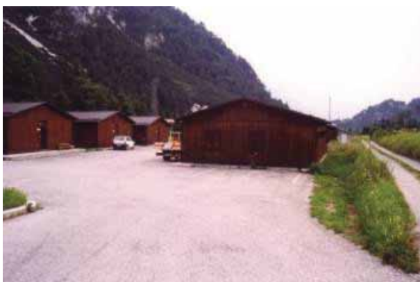
Foto 116– Baraccamenti di cantiere zona Val Canale (UD) – Foto G. Sauli
