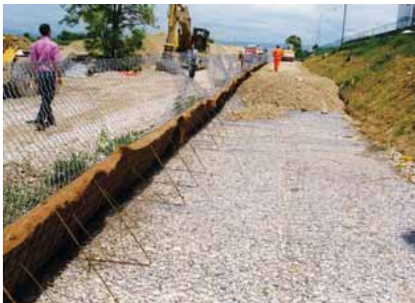
Foto 53 - TRV con rinforzi orizzontali in rete metallica (A4 Casello di Villesse – Foto R. Ferrari)
