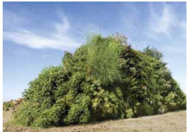
Foto 78 – Barriera antirumore vegetata ad arbusti in terrapieno compresso in struttura metallica. Campione di recente realizzazione con cura particolare per il suolo di riempimento (suolo tecnogenico) ed evidente successo dello sviluppo della vegetazione. (Foto G. Sauli)
