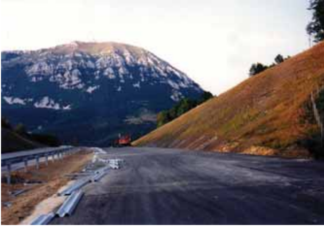
Foto 1 - Scarpata in trincea in roccia lavorata a bassa pendenza e a tirata unica senza berme intermedie. Autostrada Capodistria-Lubiana, Località Razdrto (Slovenia). Foto G. Sauli
