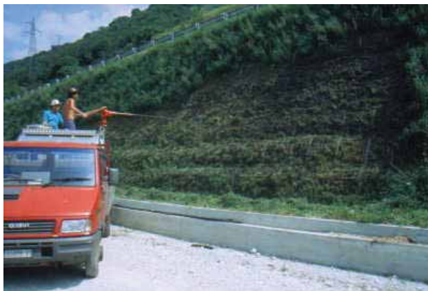
Foto 49 - Idrosemina di rinalzo su TRV (Autostrada V.Veneto - Pian di Vedoia – foto G. Sauli 1989)
