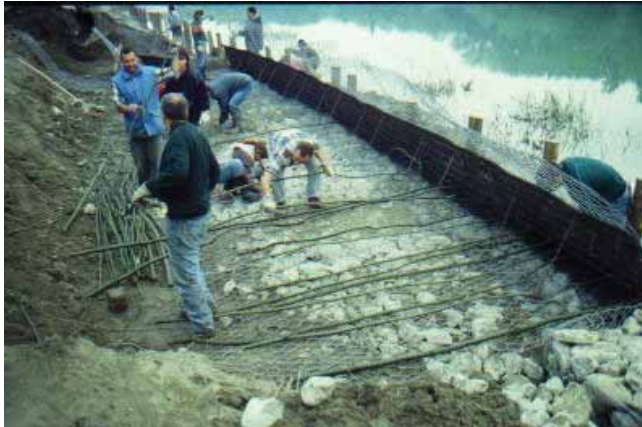
Foto 109 – Consolidamento spondale in terra rinforzata verde con talee di salice (Fiume Reno – BO – Foto G. Sauli)
