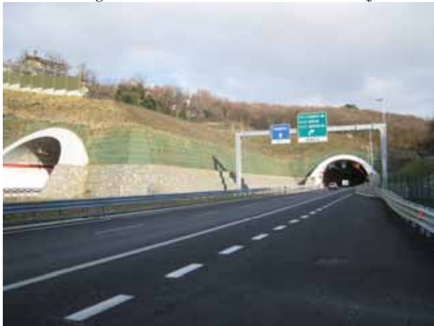
Foto 51 - L'uso di feltri sintetici come antiersosivo nelle TRV non consente la crescita del cotico erboso (Galleria Rabuiese GVT-TS - foto G. Sauli 2009)
