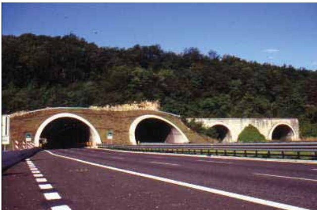
Foto 5 - a destra vecchio portale in cls, a sin nuova tipologia rivegetabile con semine e vimate. (Foto G. Sauli)
