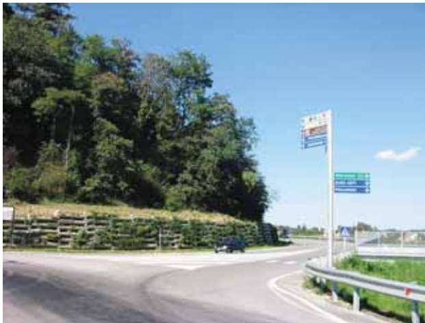
Foto 67 – Svincolo SS 231 – SP 134 CN (Foto R. Santero)
