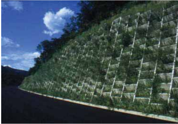
Foto 65 - Muro a nicchie cellulari in terra armata con piantagione di arbusti (Autostrada dei Trafori – Foto G. Sauli 1990)
