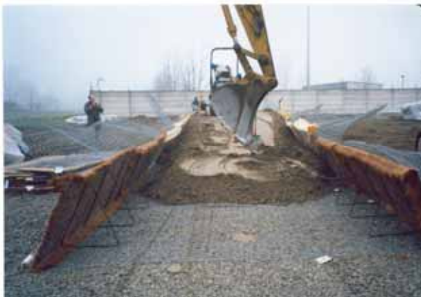
Foto 81 – Barriera antisvio in doppia terra rinforzata verde in fase di costruzione (Foto F. Ferraiolo)
