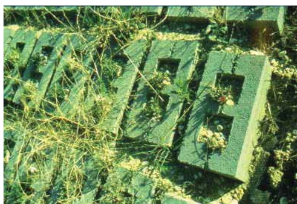
Foto 42 - Scarpate in scavo su substrato sabbioso stabilizzate con mattonelle in cls poggiate su geotessili e rivegetate con piantine di Mesembrianthemum. Dopo quasi 20 anni non c'è traccia di queste piante mentre si è affermata Inula viscosa cresciuta spontaneamente (sequenza foto 42÷44) (3° corsia Fiano-Orte c/o svincolo di Orte - Foto G. Sauli)
