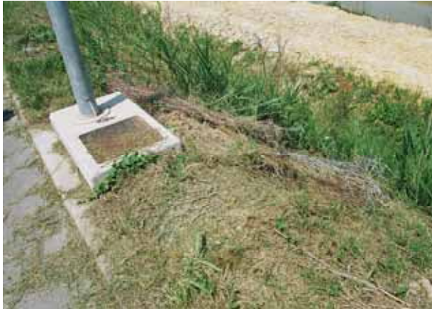
Foto 126 – idem conseguenza dell'uso della barra rotante sulle reti del rivestimento vegetativo ( Foto G. Sauli 2006)
