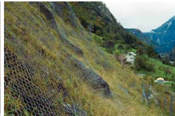
Foto 48 - Rivestimento vegetativo in geostuoia tridimensionale e rete zincata inerbata su scarpate in scavo in litologia sciolta su detrito di falda (Autostrada Carnia -Tarvisio – Foto G. Sauli ottobre 1987)
