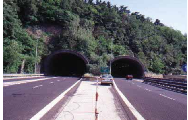
Foto 12 - GVT Galleria di Servola (TS) – dopo 10 anni (Foto G. Sauli)
