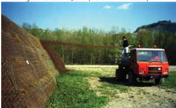
Foto 81 – Barriera antisvio in doppia terra rinforzata verde in fase di costruzione (Foto F. Ferraiolo)
