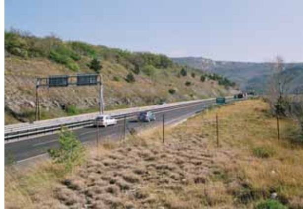
Foto 46 - Scarpate in rocce marnoso-arenacee rivestite con sola rete metallica. Lo sviluppo spontaneo della vegetazione è legato alla presenza di piccole berme su cui si è accumulato materiale terroso fine. (GVT svincolo Grandi motori – TS – Foto G. Sauli 2010).
