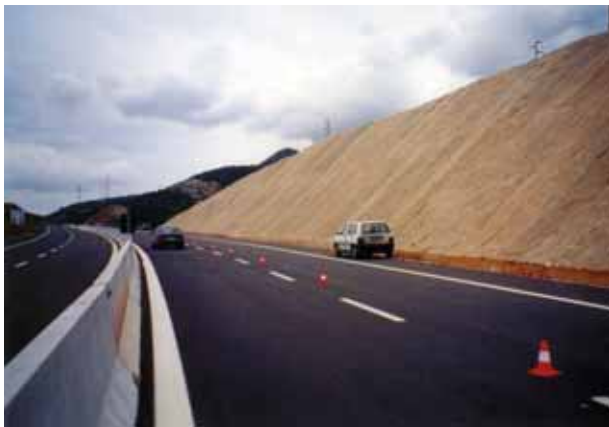
Foto 47 - Reti metalliche e stuoie organiche su scarpate in scavo in condizioni di forte aridità non sempre producono rivegetazione, pur mantenendo la funzione di stabilizzazione. (Sardegna SS 195 Pula – Foto G. Sauli fine anni '80)
