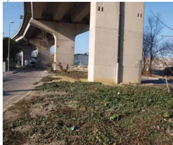
Foto 86 – Impiego delle acque di sgrondo mediante tubi diffusori per rivegetazione ad edera (Grande Viabilità di Trieste – Via Caboto) gennaio 2010. Foto G. Sauli
