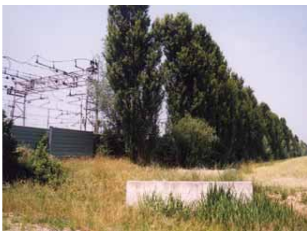
Foto 33 - Fascia boscata di 10 m di larghezza dopo 20 anni dalla realizzazione (scalo ferroviario di Cervignano del Friuli – UD – Foto G. Sauli)
