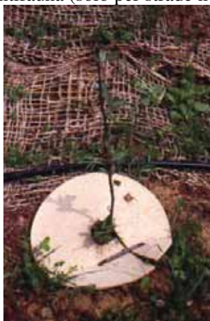
Foto 17 – Messa a dimora di arbusto con disco pacciamante e impianto di irrigazione a goccia (foto G. Sauli)
