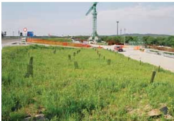
Foto 13 - Esempio di prerinverdimento di scarpate stradali si notino le reticelle antifauna a protezione degli arbusti (GVT Loc. Padriciano - Foto G. Sauli)
