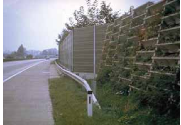
Foto 74 – Barriera antirumore in terrapieno compresso in cls vegetata (Austria anni '80). Foto G. Sauli
