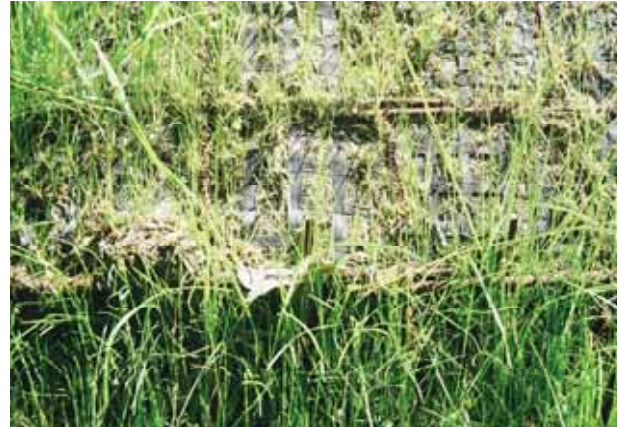
Foto 56 - Messa a dimora di talee di salice su TRV con griglie metalliche, reti sintetiche e stuoie nella sequenza dall'esterno verso l'interno (GVT - Foto G. Sauli 2009)
