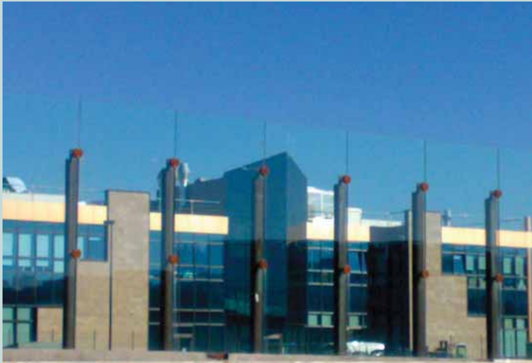
Fig. 119 Firenze. Pannelli antirimore in vetro in ambito urbano. (Foto G. Gibelli)
