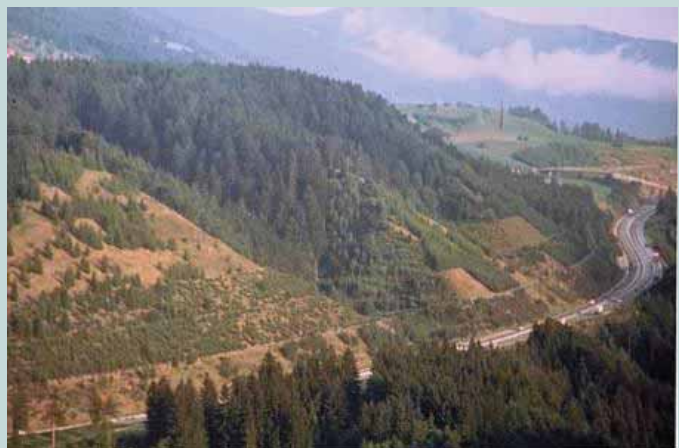
Figg. 107, 108, 109 Autostrada del Brennero (Austria). Modellamento del terreno per la realizzazione dell'autostrada del Brennero cui si affiancano opere di rimboscimento e consolidamento delle aree soggette a modifica durante il 1962 (in fase di cantiere) e nel 1973, dopo undici anni dalla sua realizzazione. (Le immagini sono state gentilmente concesse da Florin Florineth).
