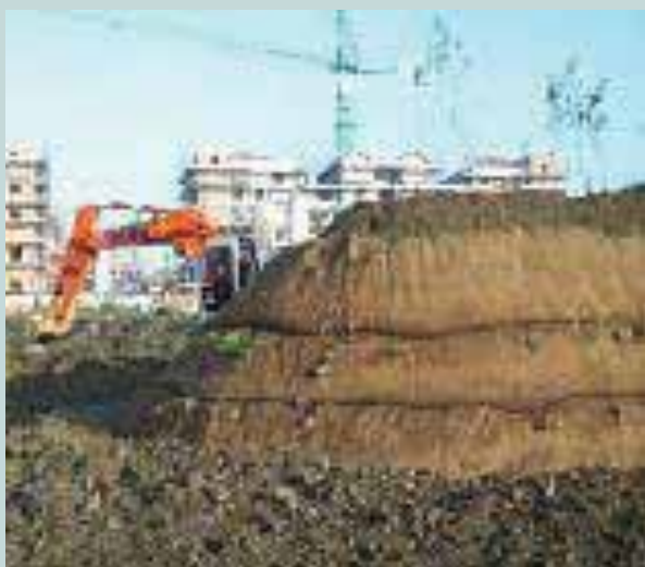
Fig. 122 Esempio di barriera antirumore, realizzata con tasche in geotessuto di cocco. Tra le tasche sono posizionate piantine radicate e talee di salice.
