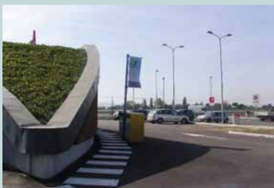
Figg. 105, 106 Autogrill autostrada E45 Mensa, Ravenna. Particolare della copertura con Heder helix e degli esterni che risultano sprovvisti di elementi verdi e di elementi per il comfort della sosta: gli stalli dei parcheggi sono, infatti, privi di ombreggiamento e le pavimentazioni sono totalmente impermeabili. (Foto M. Minelli)
