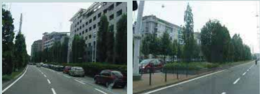
Figg. 32, 33 Torino. Adeguamento della viabilità nella zona del nuovo passante ferroviario. (Foto M.Minelli)
