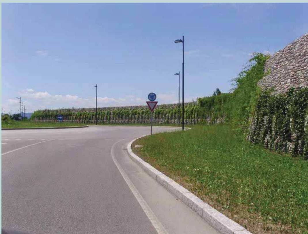
Fig. 125 Castelmaggiore (Bo) Muro di gabbioni metallici rinverdito con rampicanti per raccogliere le polveri inquinanti derivate dal traffico veicolare e con funzioni di limitazione della rifrazione e dell'irradiazione di luce e calore. Il cambio di specie utilizzata è in funzione della diminuzione della velocità necessaria in prossimità della rotonda (Foto M. Minelli)
