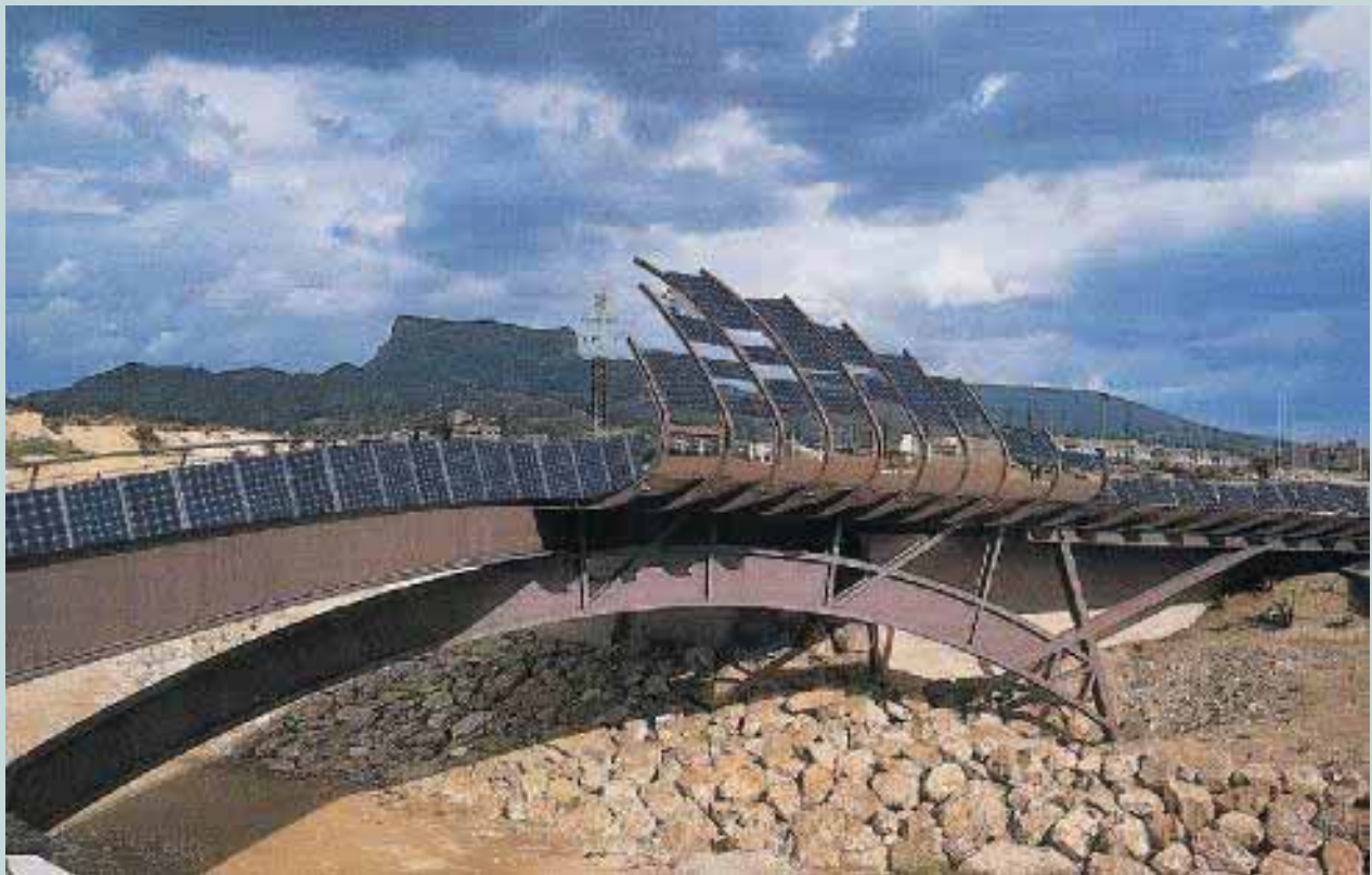
Fig. 116 La forma irregolare si presta molto bene per gli inserimenti nei paesaggi naturali o naturaliformi. I parapetti dei ponti possono essere impiegati per produrre energia. Fotomontaggio del ponte in ferro di Carmen Pinòs (Spagna).
