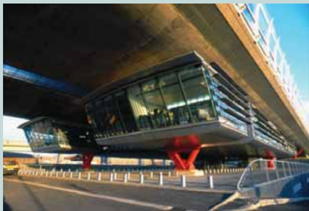
Figg. 28, 29, 30 Nanterre, Parigi. Il viadotto d'accesso all'autostrada A14, progettato da Odile Decq e Benoît Cornette, è collocato sul tragitto Paris La Défense in direzione Normandia, appena prima del ponte che attraversa il fiume a Carrières sur Seine (foto sopra). Il nuovo ponte è progettato per ospitare sotto di sé il Centro di Gestione delle Autostrade (foto sotto).
