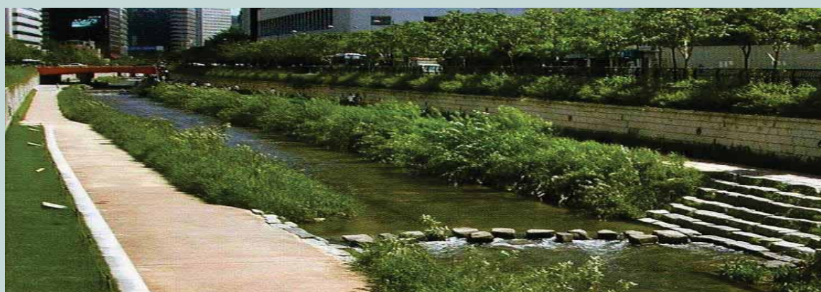
Figg. 25, 26, 27 Fiume Cheonggyecheon (Corea). L'asse di scorrimento veloce urbano (immagine in alto a sinistra) è stato interrato in corrispondenza del fiume il corso era stato precedentemente tombato. Il fiume è tornato alla luce e alla vita sopra l'infrastruttura a vantaggio della città, degli abitanti e della sicurezza idraulica.
