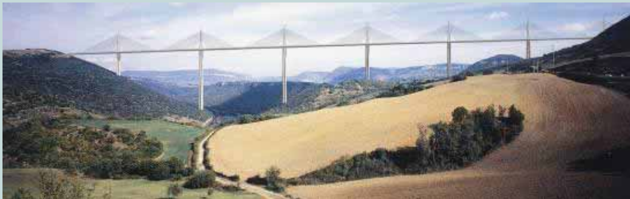
Fig. 112 Il viaduc du Millau (Francia). Particolare attenzione è stata posta alla fase di cantiere. I paesaggisti (M. Desvigne e C. Dalnoky) hanno utilizzato la trama delle siepi per mitigare gli impatti in fase di costruzione recuperando e preservando il paesaggio esistente dal cantiere grazie al suo inserimento all'interno della trama dei campi. Nella fase di esercizio tale maglia ospita le aree di sosta e i parcheggi: la trama dei campi diviene quindi la struttura portante che accoglie in sé le trasformazioni future. (Foto gentilmente concessa dalla Directions des Routes, France)
