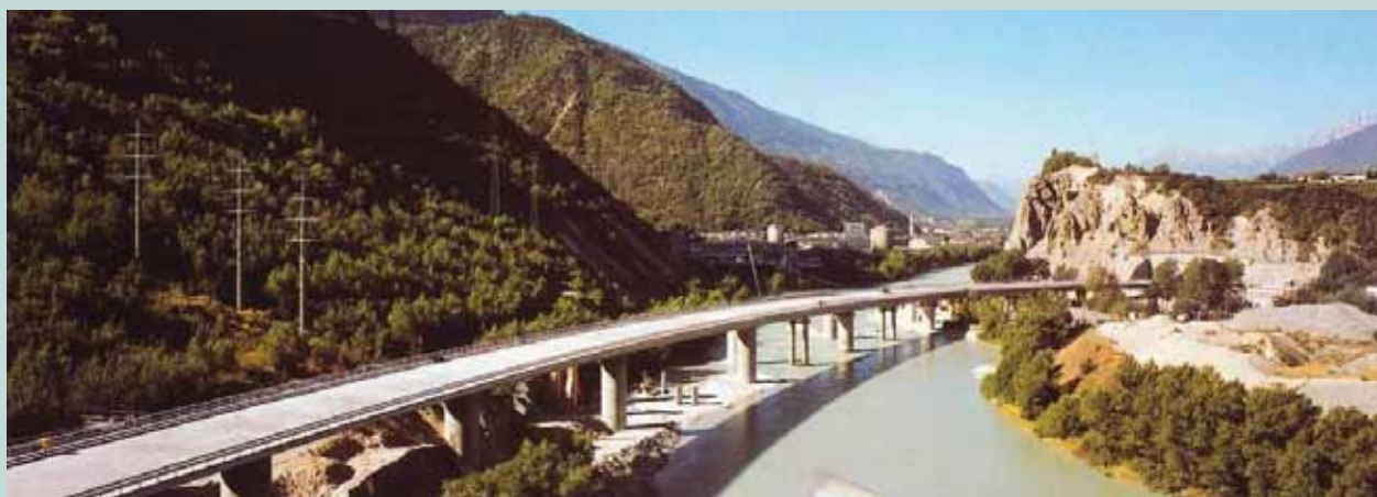
Fig. 113 Viaduc de l'Ile Falcon (Svizzera). L'autostrada A9 contorna il sud della città di Sierre e, allontanandosi ad est dall'abitato dopo aver attraversato le colline di Géronde in tunnel e costeggiato la parte meridionale della zona industriale dell'Ile Falcon, scorre sulla piana e attraversa il fiume Rodano grazie ad un viadotto lungo 750 m che passa attraverso delicati ecosistemi fluviali. (Foto gentilmente concessa dall'Office de construction des routes nationales du Valais, A9, Svizzera).
