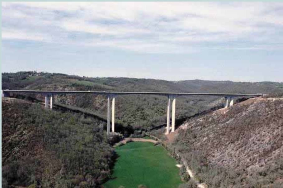
Fig. 110 Autoroute A20 – Cahors nord/Souillac (Francia). Nella fase di cantiere si è prestata molta attenzione al sito e alle sue componenti naturali ed ecologiche. Durante i lavori il corso d'acqua è stato protetto lasciando il più possibile intatto il relativo fondovalle.
