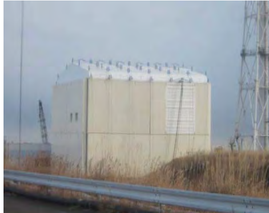
Fig. 5 Copertura ultimata dell'edificio reattore dell'Unità 1.
