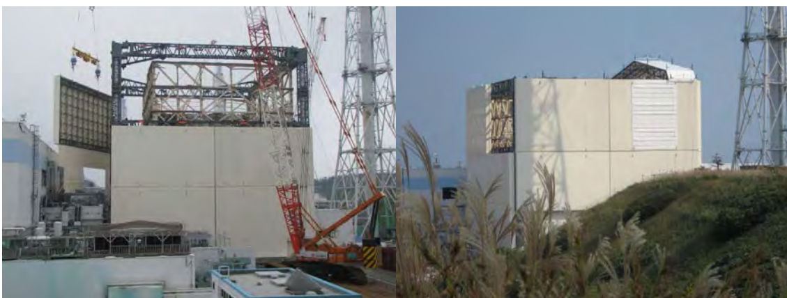
Fig. 3 e 4 Fasi di copertura dell'edificio reattore
