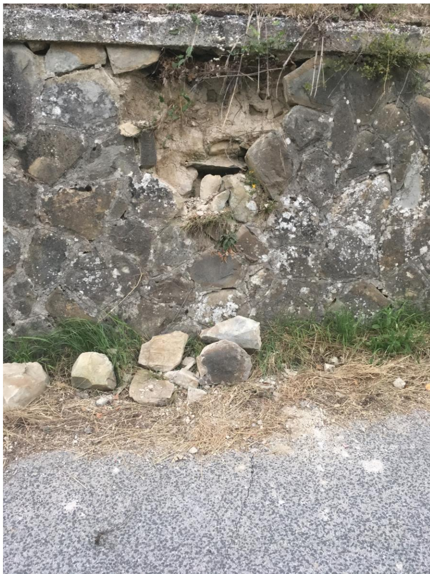
Figura 2 - Fratture minori sul manto stradale e piccolo crollo nei pressi di Cossito.
