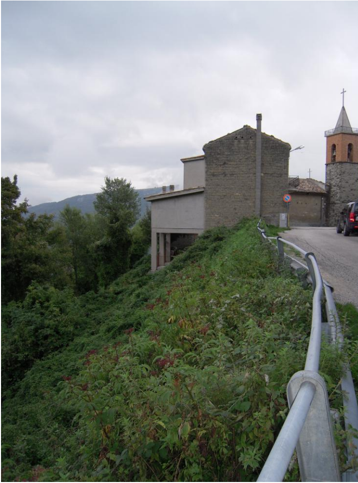
Fig. 5 – Inclinazione e scivolamento verso valle del guardrail
