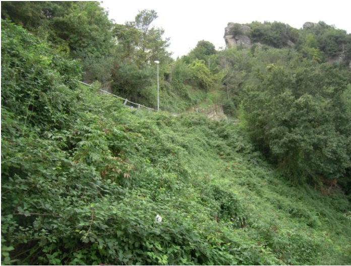
Fig. 3 – Vista laterale dell'area in frana.
