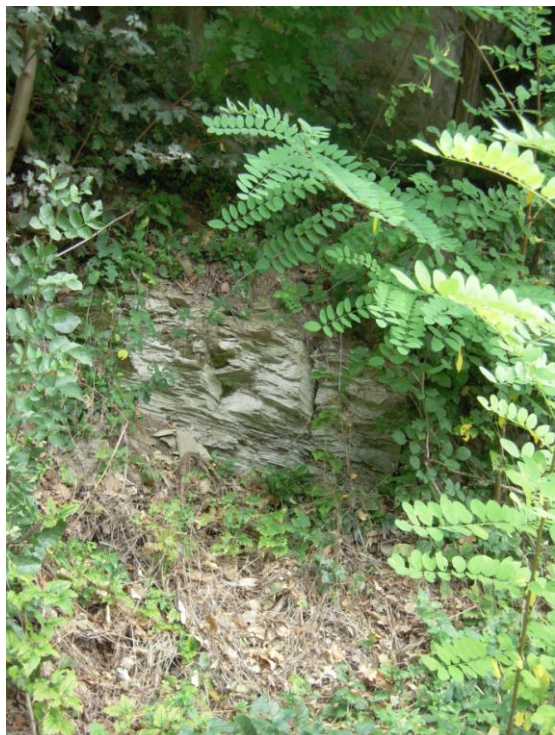
Fig. 2 – alternanze di bancate lapidee arenacee e livelli pelitici, appartenenti alla formazione del Flysch della Laga, affioranti lungo il pendio interessato dal sopralluogo.
