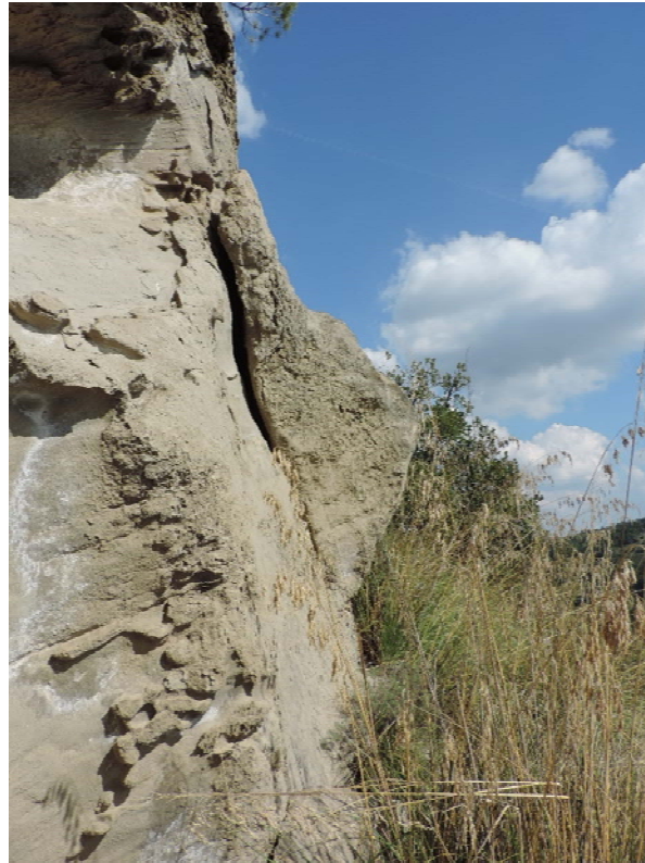
Figura 4. Dettaglio del blocco instabile (blocco B).
