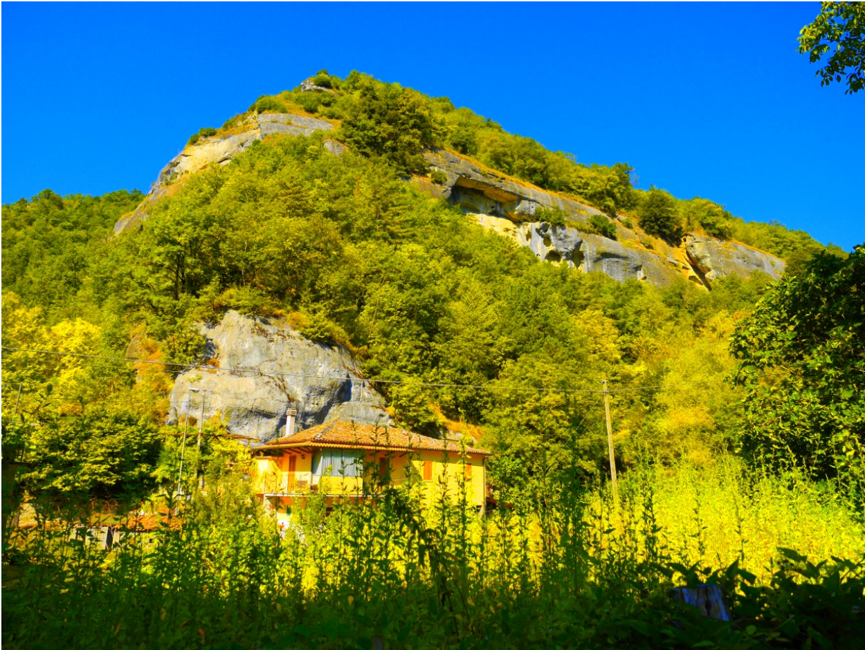
Figura 2 - Panoramica del tratto interessato dal rilevamento. Si notano blocchi aggettanti di rilevanti dimensioni
