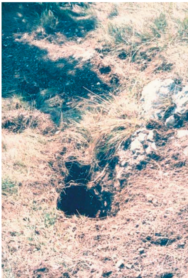
Fig. 2 - Fenomeno di sprofondamento nei pressi della cava di Cordignano (TV)
