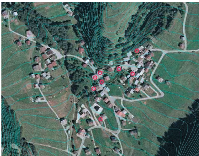
Fig. 3 - Diffusione di fenomeni di sprofondamento nell'abitato di Andrich, comune di Vallada Agordina (BL)
