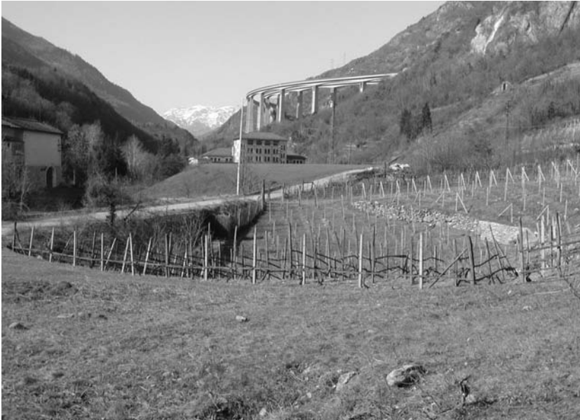
Fig. 1 – Sinkhole A presso Chiomonte
