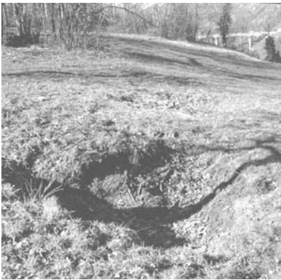
Fig. 3 – Piccolo sprofondamento presso Chiomonte.
