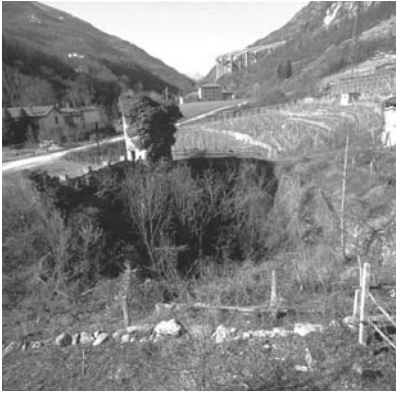
Fig. 2 – Sinkhole B presso Chiomonte
