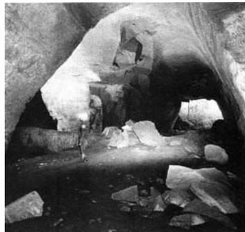
Fig. 2- Esempio di crolli dalla volta di una cavità
