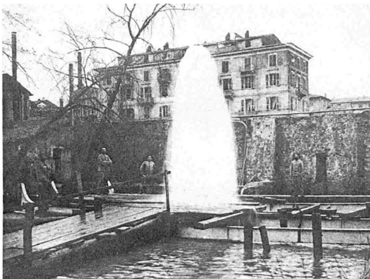
Fig.3 - fuoriuscita di acqua in pressione dal tubo infisso nella sprugola all'interno dell'Arsenale militare
