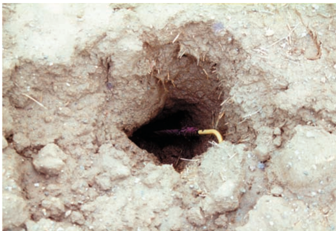
Foto 4 - Sinkhole nello stadio di maturazione
