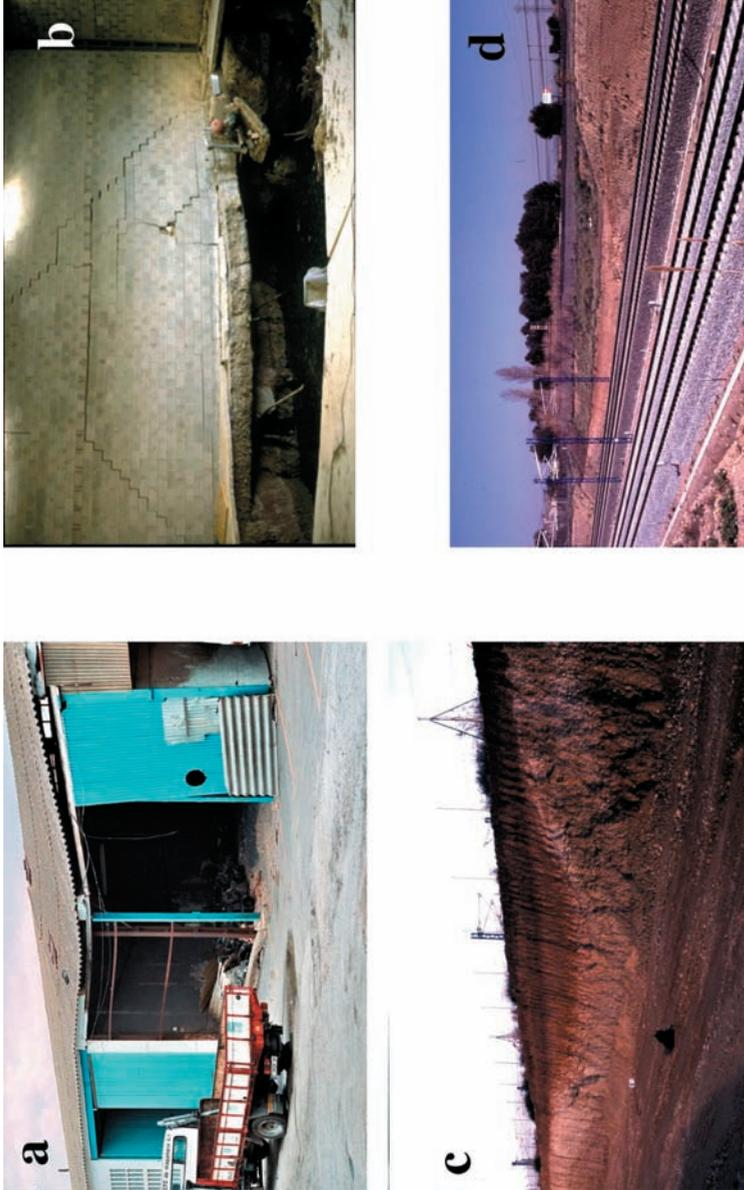
*Figura 5. a. Deformación que afecta a una nave industrial (1 en figura 6). b. Colapso en el interior de una nave industrial al NW de Zaragoza. c. Estructura interna de una dolina contigua a la vía del AVE (2 en figura 6). d. Talud de las líneas ferroviarias que atraviesan una dolina (3 en figura 6). Se observa la terraza cuaternaria deformada y el relleno antrópico.*
