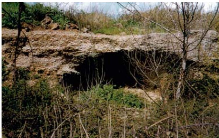
Fig. 9 - Galleria a sezione semicircolare, di ingresso alla rete caveale sotterranea, impostata direttamente negli strati di ghiaia, oggetto dell'attività estrattiva, e situata nella pianura valliva percorsa dal fosso senza toponimo (vedi carta geomorfologica).
