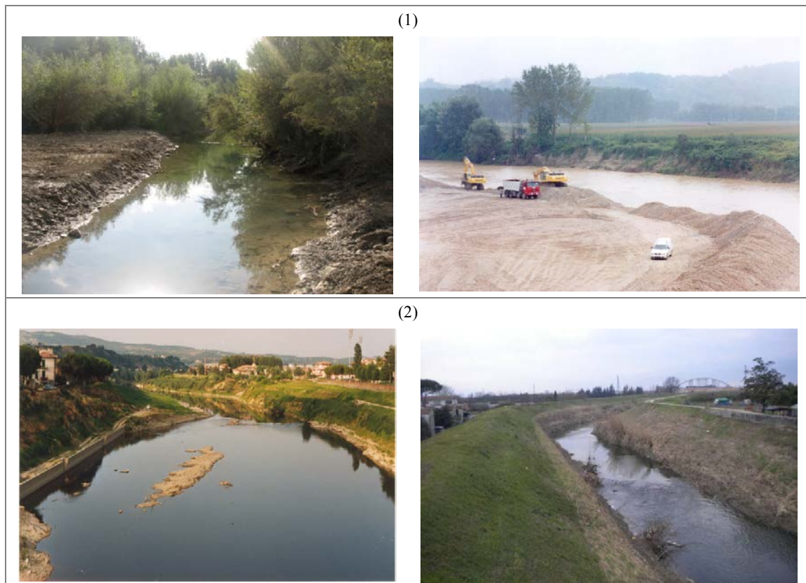
Figura A4.40 – Alterazioni della variabilità della sezione in alvei semi- non confinati. (1) Casi di parziale omogeneizzazione della sezione per interventi di riprofilatura; (2) omogeneità della sezione per tratti estesi a causa di eccessiva artificializzazione.
