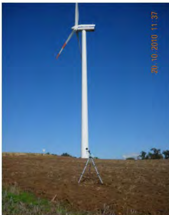
Figura 1: Aerogeneratore Vestas V90
