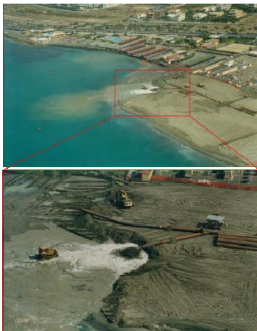
Figura 1.5.1 - Operazioni di ripascimento (Foto Regione Lazio).
