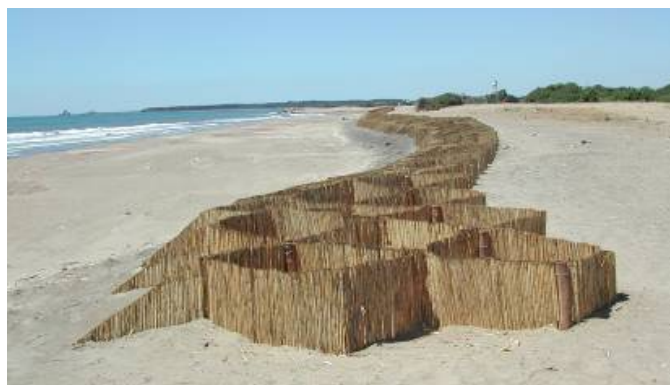
Figura 1.8.2 - Barriera frangivento a scacchiera (POSIDUNE, 2007).
