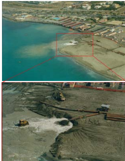
Figura 1.5.1 - Operazioni di ripascimento (Foto Regione Lazio).
