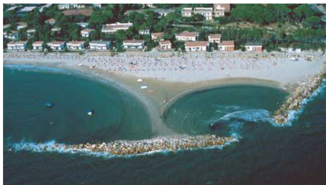
Figura 3.4.6: La prima "foto obliqua" illustra un esempio di protezione del litorale con "opere di difesa miste", costituite da barriere e pennelli disposti in varie direzioni rispetto all'andamento della linea di riva. La seconda foto (Prato Ranieri, Toscana) mostra più in dettaglio delle opere di difesa di tipo misto costituite da una barriera emersa ed un pennello, disposti obliquamente rispetto alla linea di riva secondo la direzione di propagazione del moto ondoso prevalente (Regione Toscana).
