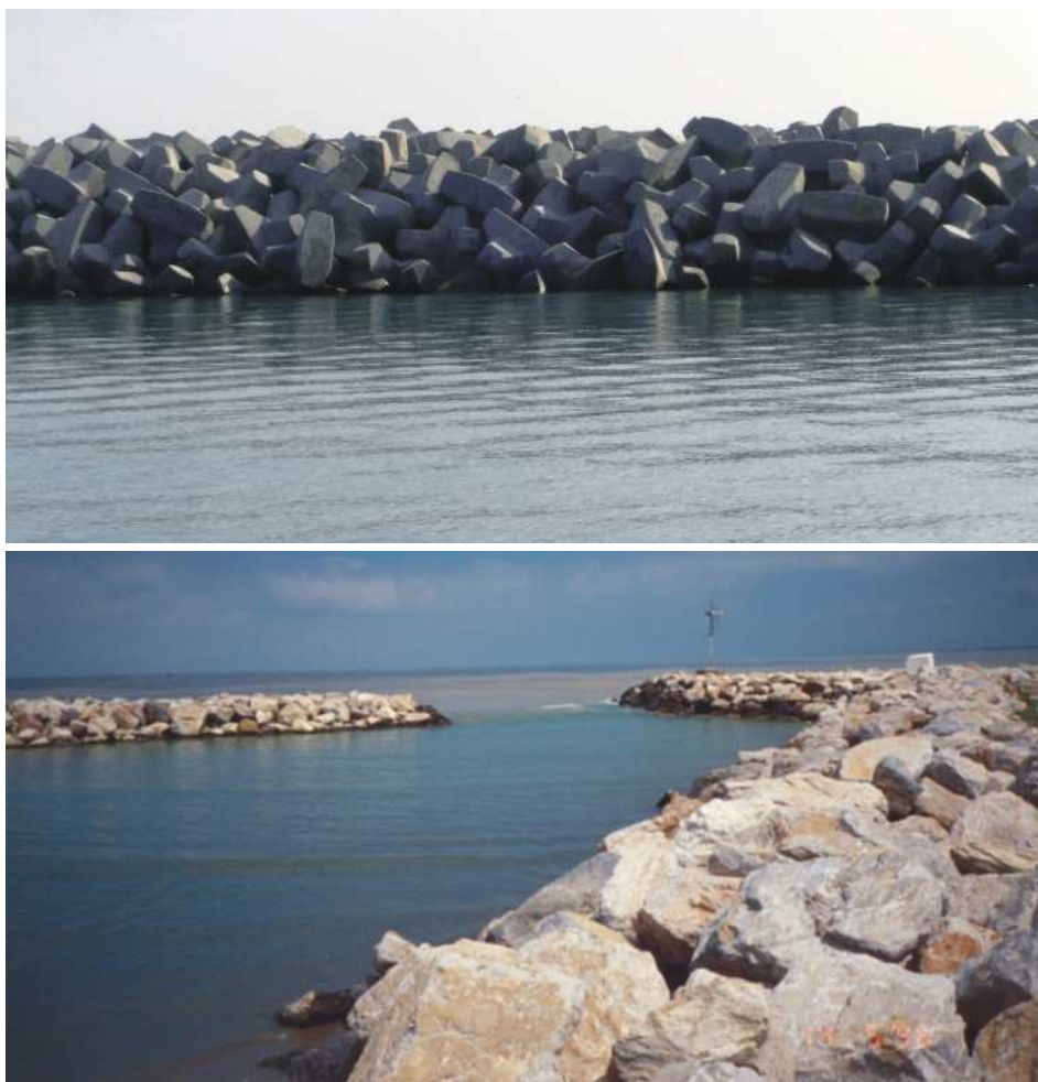
Figura 3.4.3: Opere di rivestimento di scarpate costituite da massi naturali ed artificiali (accropodi) all'interno della Laguna di Venezia (Corsini S.).
