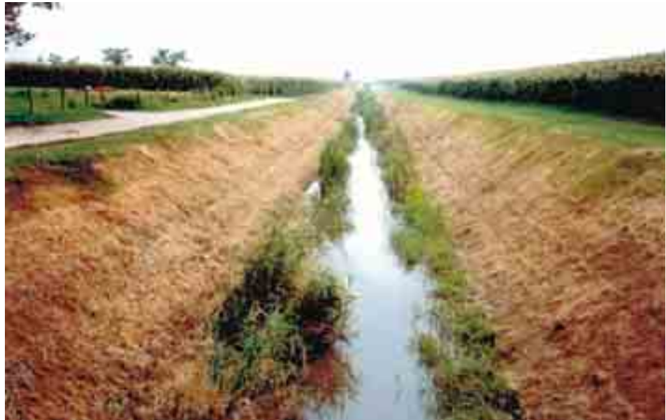
Figura 4.1.3: Canale terziario di un sistema di bonifica. Caratterizzato dalla tipica sezione trapezoidale e fondo stretto, è stato fotografato in un momento di magra, in cui la funzione che svolge è quella di prosciugamento dei terreni circostanti coltivati a mais.
