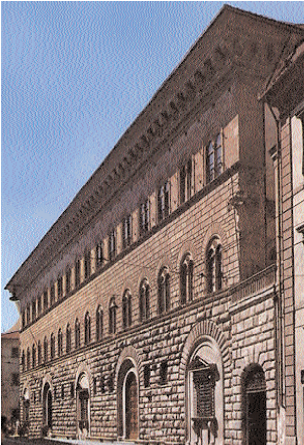
Fig. 5 - La facciata quattrocentesca di Palazzo Medici a Firenze, con rivestimento di bozze e conci di pietra forte (foto M. Mariottini).
