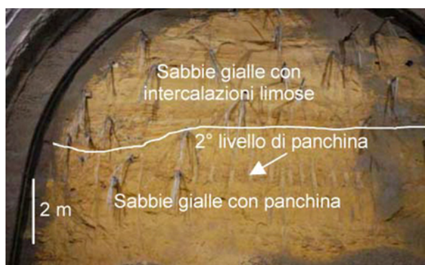
Fig. 10 - Limite stratigrafico, su superficie erosiva, tra le Sabbie gialle con panchina e le soprastanti Sabbie gialle con intercalazioni limose. Quest'ultimo membro è caratterizzato da sabbie medio-grossolane e intercalazioni di livelli argilloso-limosi ocrei. Galleria naturale esterna, progressiva 1253 m.
