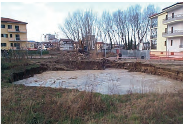
Fig. 62 - Immagine del sinkhole di via Udine del 7 febbraio 2002 (fonte: www.vivitelese.it ). - View of 2002 February 7 sinkhole in via Udine (from: www.vivitelese.it ).
