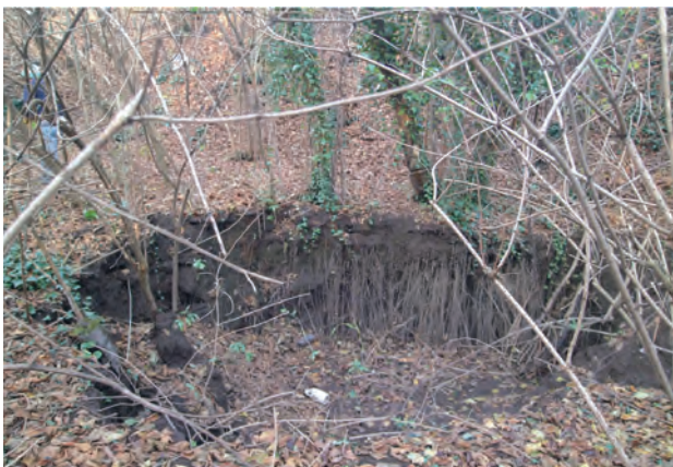
Fig. 73 - Evidenze di riattivazione sul fondo del sinkhole For005. - Reactivation evidence of For005 sinkhole phenomena.
