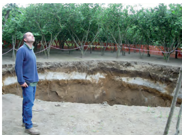
Fig. 76 - Il sinkhole di Contrada Petrosa pochi giorni dopo la sua formazione (25 giugno 2005; diametro circa 12 m e profondità di circa 25 m). - The Contrada Petrosa sinkhole few days later its formation (2005, June 25; diameter 12 m about and deeping 25 m about).
