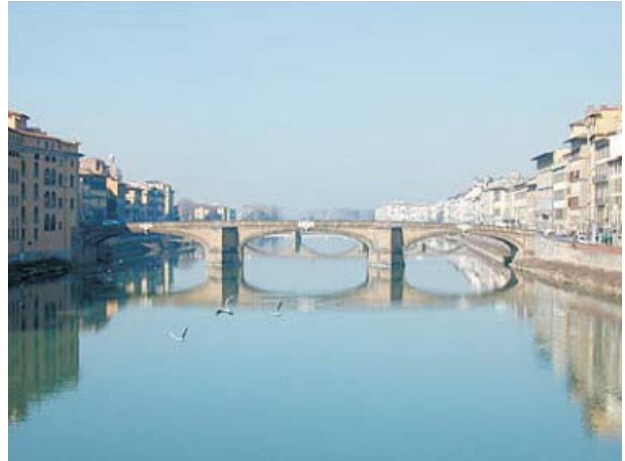
Fig. 1 – The Santa Trinita bridge in Firenze. – Ponte di Santa Trinità a Firenze.
