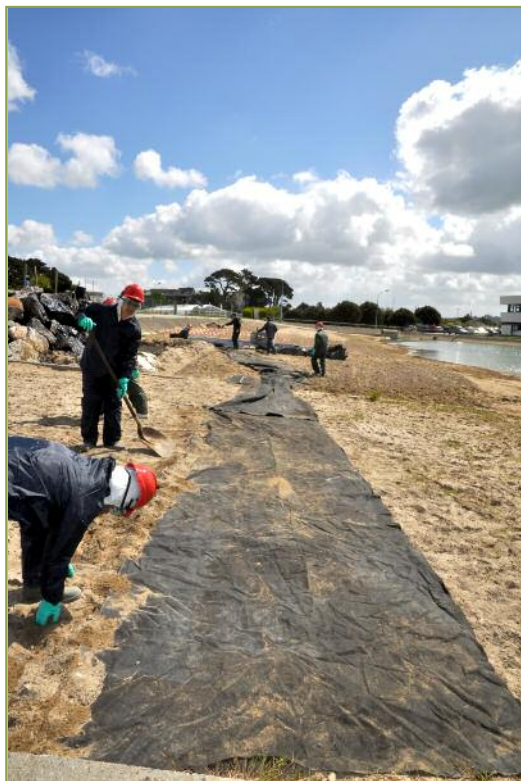
Figura 28: Copertura dell'area di passaggio per gli operatori con geotessuto o materiale assorbente (fonte CEDRE)
