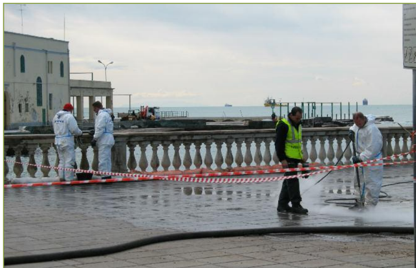
Figura 29: Bonifica di una struttura antropica impiegando una idropulitrice
