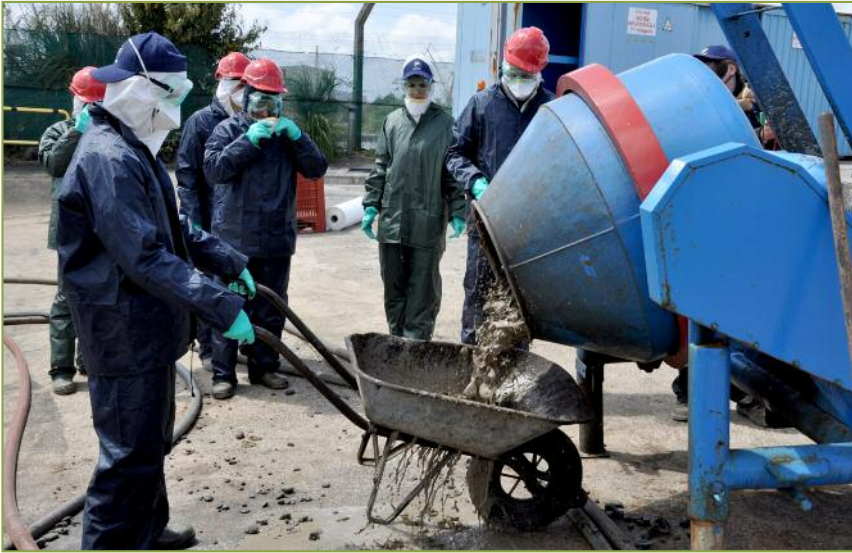
Figura 34: Lavaggio dei ciottoli in betoniera (fonte CEDRE)
