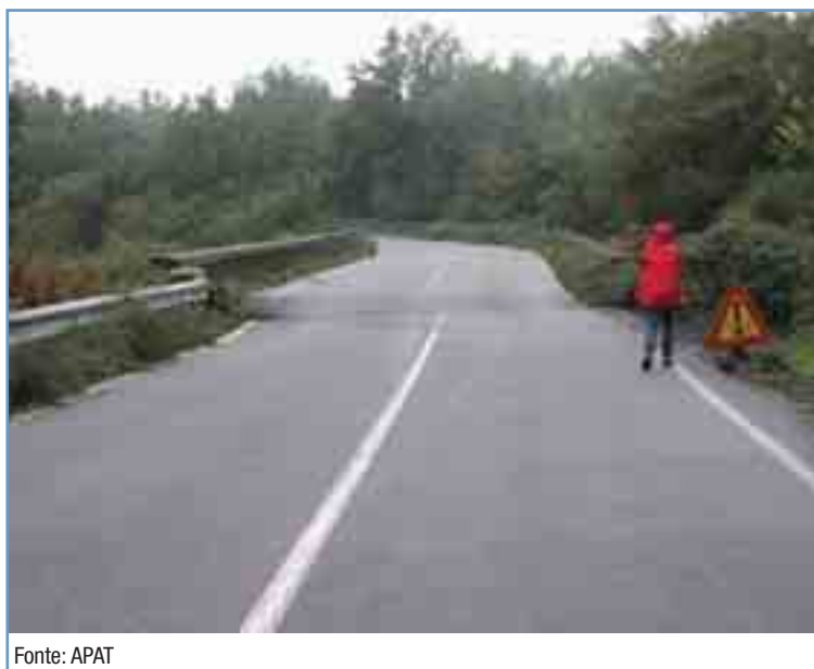
Figura 18.3: Danni provocati dalla dislocazione per creep della faglia Pernicana (trascorrente sinistra) alla infrastruttura viaria nei pressi di S. Alfio (CT)
