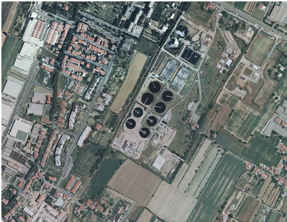
Figura 12: veduta aerea dell'impianto di depurazione di Baciacavallo – Prato
