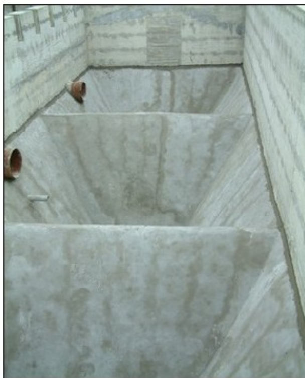
Figura 15: vasca di alloggiamento dei sedimentatori lamellare (tramogge per l'accumulo del fango)
