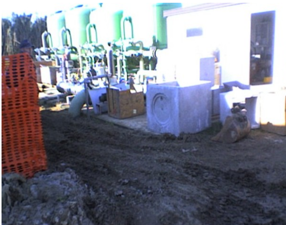
Figura 23: Lavori di completamento dei sistemi di filtrazione a sabbia quarzifera e di disinfezione con raggi UV
