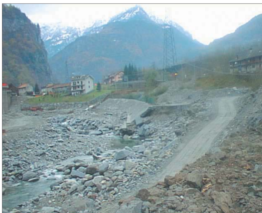
Foto 12-2: Panoramica dell'area della discarica sul torrente Diveria. In sinistra orografica, sulla scogliera di protezione, si notano ingenti fenomeni erosivi di sponda.
