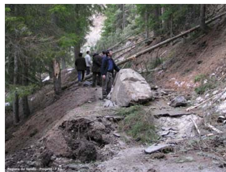
Figura 10.8 Particolare dei danni arrecati alla strada comunale dall'evento dell'aprile 2004.
