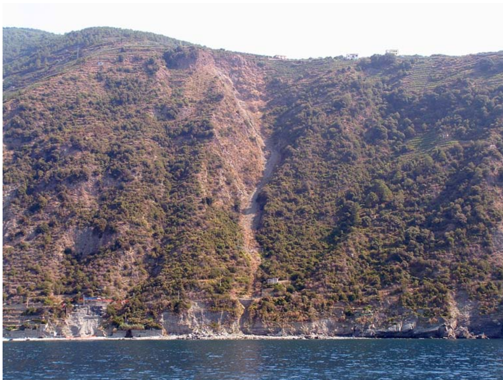
Figura 12.15 Frana di Volastra, Comune di Riomaggiore.
