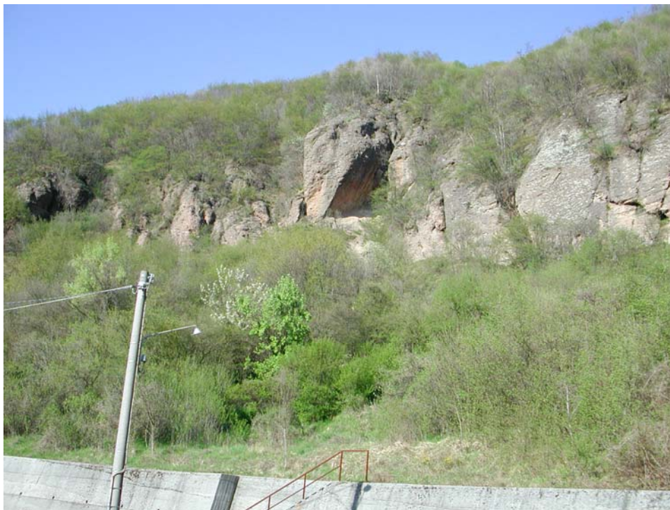
Figura 12.8 Frana in località Pietrafraccia, Comune di Ronco Scrivia.
