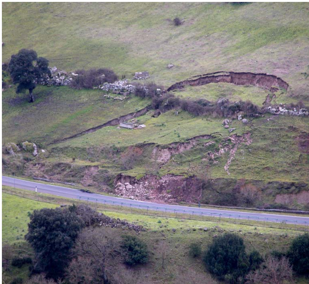
Figura 25.12 Fenomeni di scivolamento rotazionale a ridosso della strada provinciale Allai-Samugheo in Comune di Ruinas (OR).
