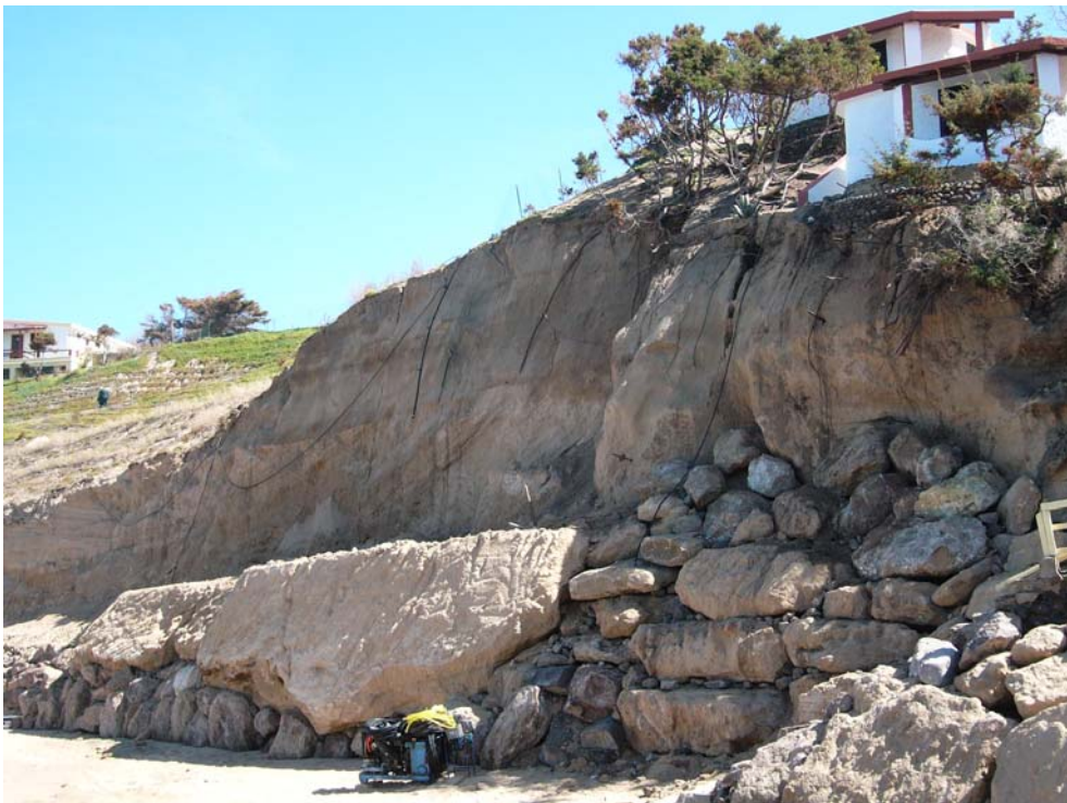
Figura 25.9 Intervento di consolidamento a carico di una parete esposta a crolli e ribaltamenti diffusi di prismi (dune fossili pleistoceniche), dovuti a scalzamento alla base per degrado progressivo da esposizione (NW) ai venti, aerosol e contributo probabile del moto ondoso, Castelsardo (SS), località Li Paddimi..
