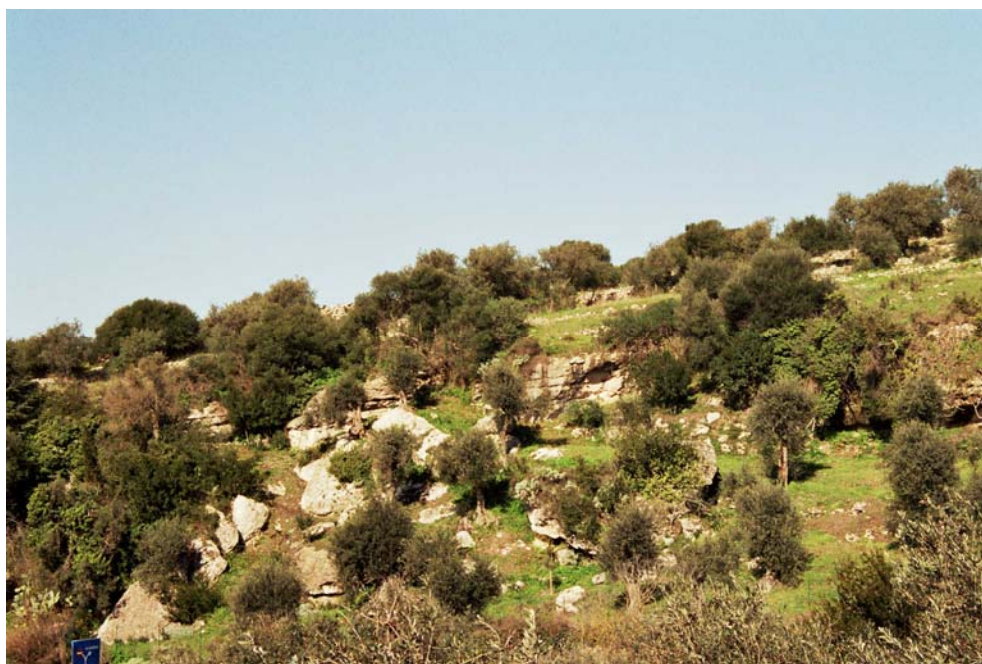
Figura 25.13 Fenomeni di crollo e ribaltamento con scivolamenti associati su litologie arenaceo-marnose; si osservano blocchi di frane stabilizzate naturalmente, Comune di Ittiri (SS).
