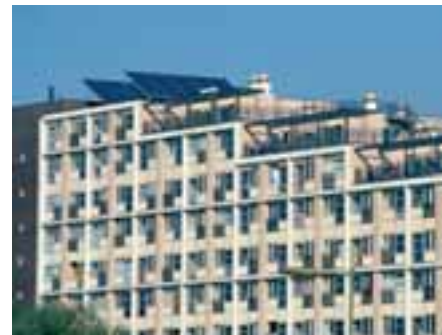
f) Impianto solare impiegato per il riscaldamento di grandi edifici residenziali – ESTIF
