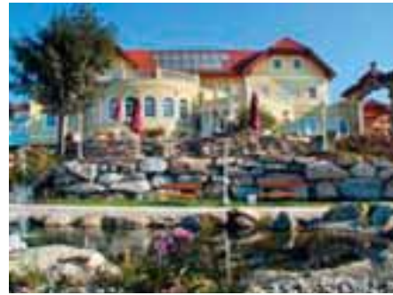
d) Impianto di riscaldamento in un albergo - ESTIF
