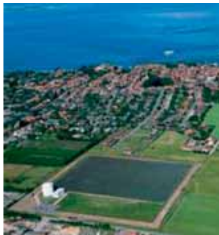
a) L'impianto solare per il riscaldamento di un distretto più grande d'Europa misura 20.000 m 2 ; Marstal, Denmark – ESTIF
