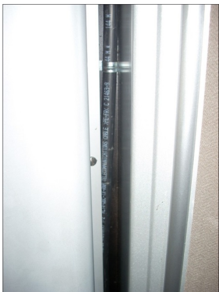
Figura 3: Vista del vano di alloggiamento apparati su ETR 600 19
