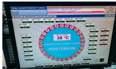
Figura 3 Sinottico in sala controllo della zona raceway con le tubiere e la temperatura di warning
